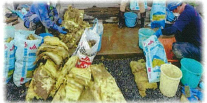
浸水したグラスウール
