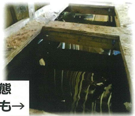
←点検口を作成して床下の確認と乾燥
