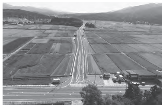
▶ 渡辺組が工事を請け負い、先月開通したばかりの国道290号。113号から臨む。ドローンで撮影
