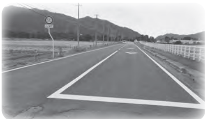
工事後の村道橋場下関線 (打上地内交通安全地蔵付近)
