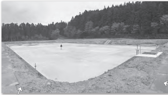
▲新設されたファームポンド（ため池）
