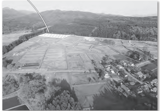
▲若山集落周辺の工事の様子（5月20日撮影）（株）渡辺組提供
