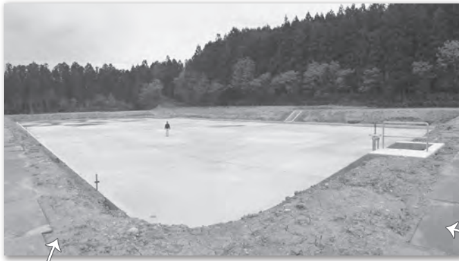
▲新設されたファームポンド（ため池）
