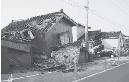
(写真上：新潟県中越沖地震被害の状況)
