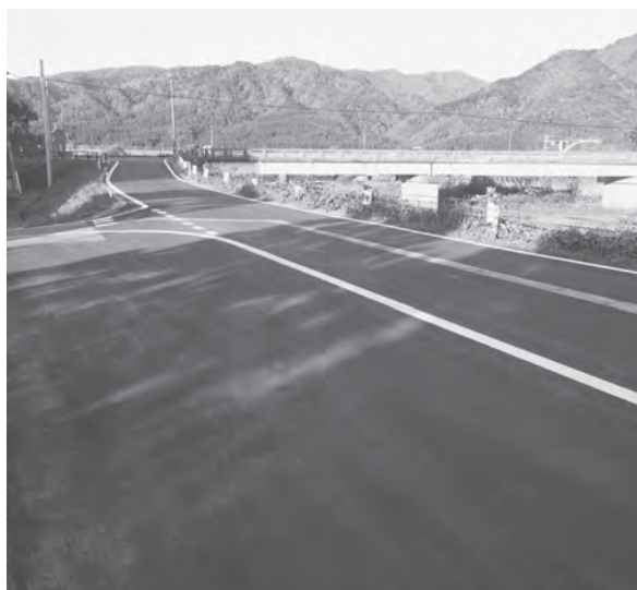
工事後の村道六本杉金保線（六本杉地内）
