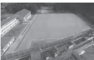
完成した関川中学校グラウンド
