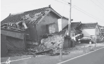
(写真上：新潟県中越沖地震被害の状況)
