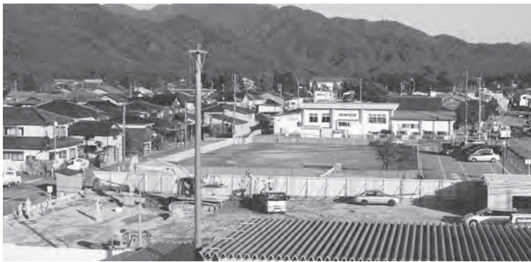
▲下関保育園グラウンド隣の建設地
