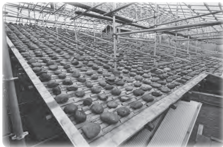
◀石置木羽葺屋根撞木造りの修復の様子
