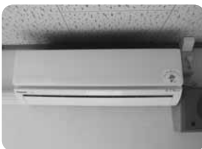
▲エアコン(就業改善センター)
