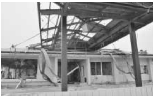
市内の沿岸部にある高齢者サービスセンター
