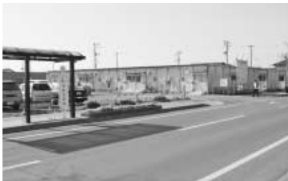
市民会館駐車場に建設された仮設住宅
