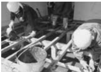
▲被災地でのヘドロの掻き出し作業
