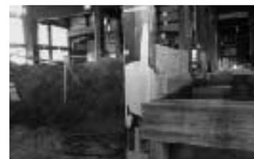
3/15現在の状況 母屋の耐震補強のため、鉄骨の骨組みを行っています。鉄骨と木部は金物で結合します。
