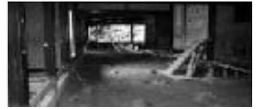
9/15現在の状況 ▷床板を全部撤去 ▷主屋の壁のかき落とし中(足場設置) 大座敷から勘定の間の床下の基礎石が見学できます
