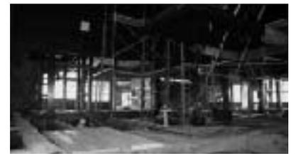
8/15現在の状況 ▷床板を全部撤去 ▷主屋の壁の土落とし中(足場設置)
