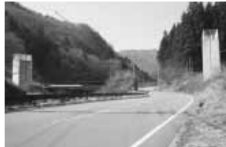
中断している鷹ノ巣道路橋梁工事 (沼地内)
