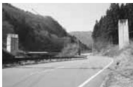
▲中断している鷹ノ巣道路橋梁工事（沼地内）
