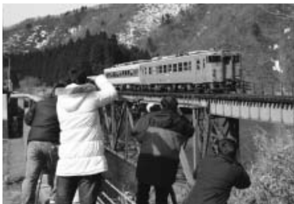
JR米坂線八ツ口地内跨線橋にて (3月9日)
