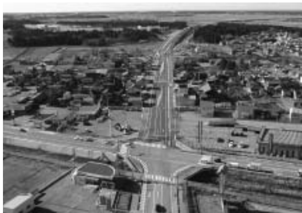
R7十文字交差点から荒川跨線橋方向を望む
