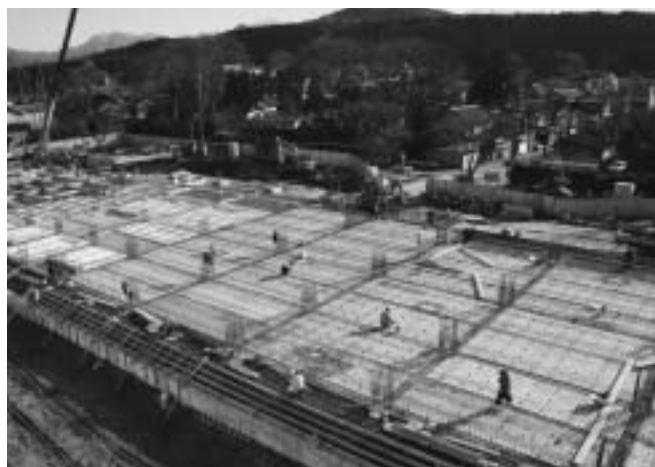
関小学校の屋上から撮影（12月2日）
