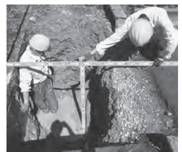
水道管漏水工事
