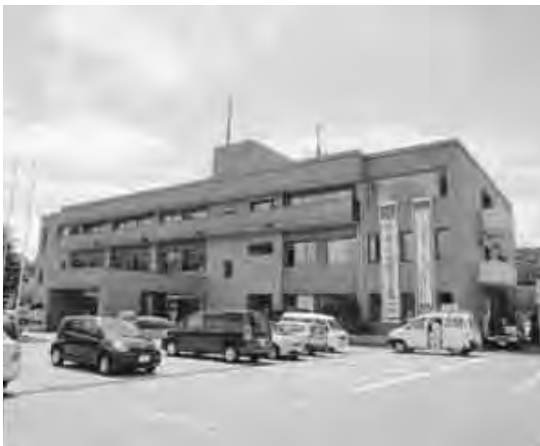
昭和54年竣工のため、耐震基準を満たしていない庁舎
