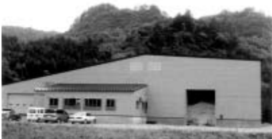
農林水産物集出荷貯蔵施設
