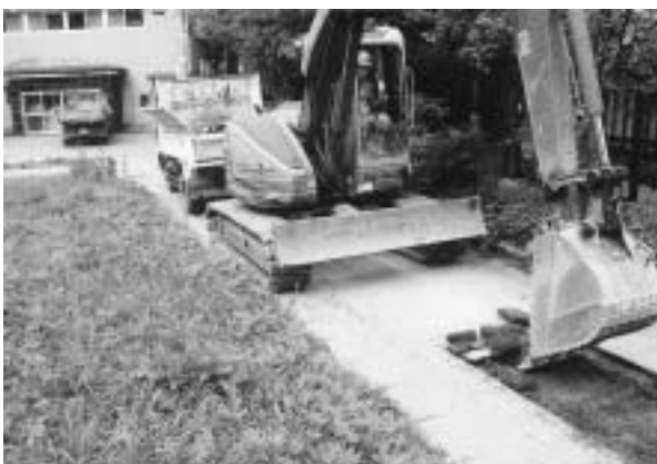
下水道工事（小見地内）
