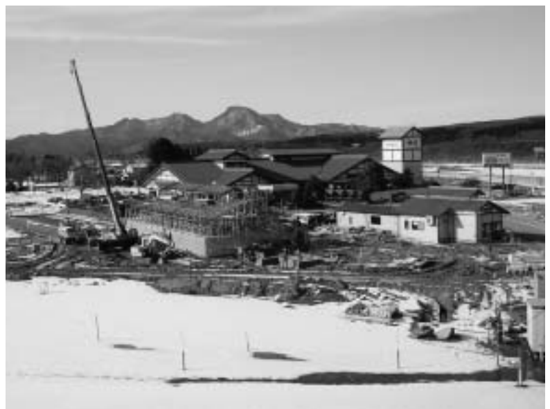
整備が進められる道の駅周辺
