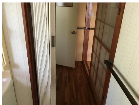
1 階廊下と手すり
