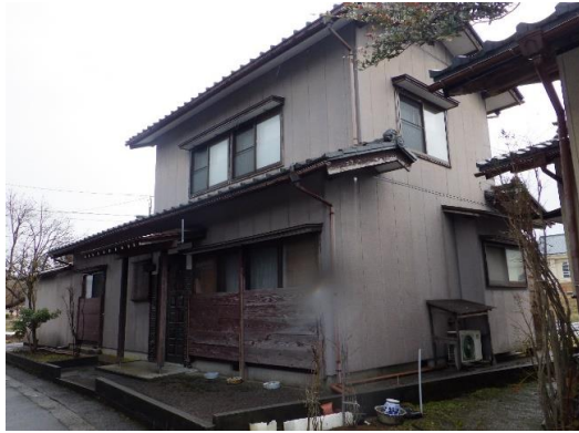
建物外観 前面
