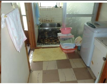
脱衣室・浴室
