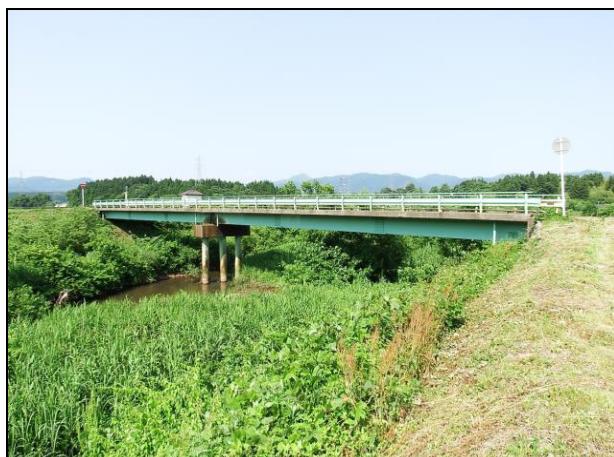
写真全景（鋼橋）
