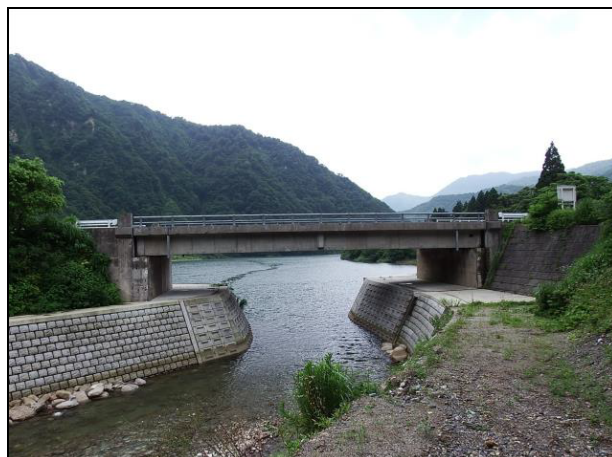
写真全景（コンクリート橋）
