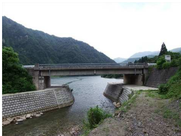
写真全景 (コンクリート橋)
