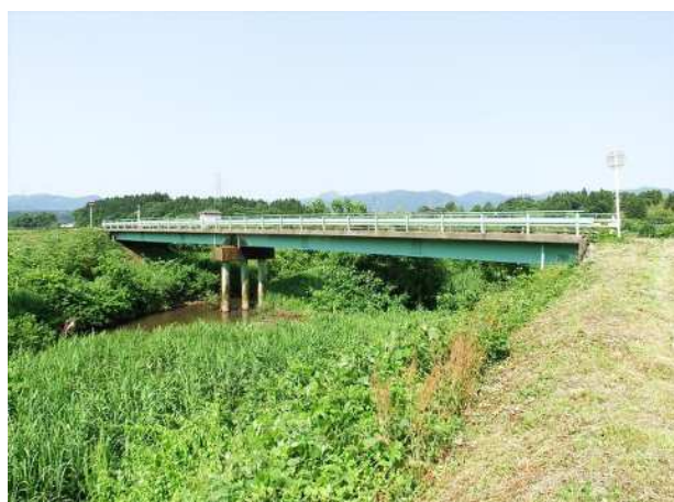
写真全景 (鋼橋)
