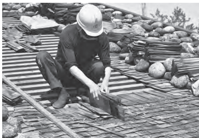
国指定重要文化財渡邊邸の屋根補修
