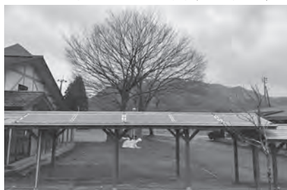
▼女川地区ふるさと会館(渡り廊下)
