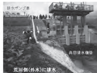
排水ポンプ車による内水排除訓練
