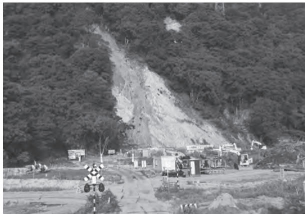
大島地内の成沢。山の斜面が大きく崩れました
