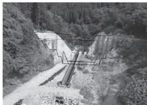
整備が進む藤沢川第3号砂防堰堤（田麦地先）
