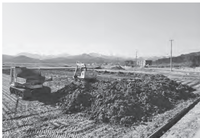
R5. 3月 土砂の撤去作業
