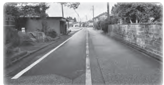
▲補修後の村道八千代打上線（辰田新地内）
