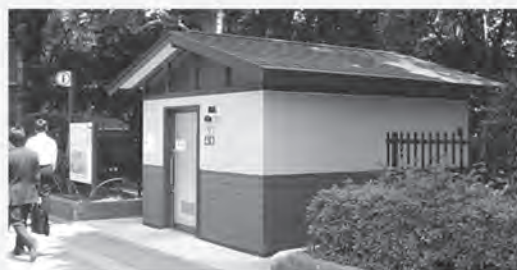
トイレ棟 観光客も利用しやすいトイレ棟を新設します。
